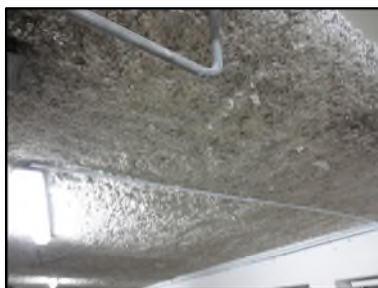
Photo N° 585 ECH-N°1 FLOCAGE -- Parking Plafonds Blanc cotonneux
